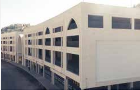
مشروع مخازن سقف السيل – عمان
